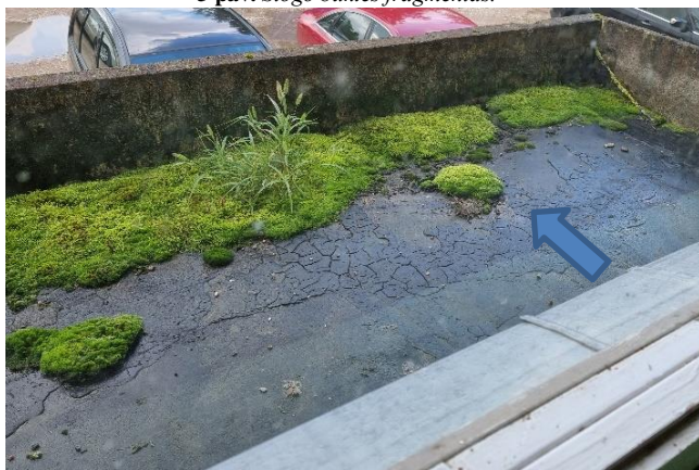
5 pav. Iejimo stoginēs (-iu) būklēs fragmentas.
